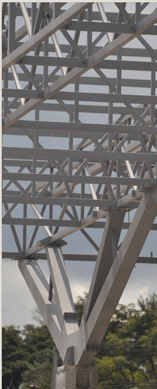
Além da cobertura das plataformas, as torres de elevadores, a torre de circulação vertical, a rampa, a fachada do prédio anexo, as estruturas para suporte de luminárias, calhas, platibandas das plataformas e suporte para policarbonato também foram projetadas, fabricadas e montadas pela PlanMetal.
