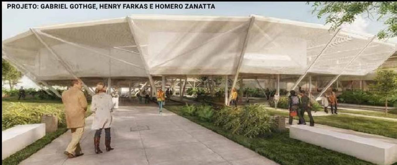
Sob outro prisma, ainda de acordo com o professor que dirigiu as equipes da USP, 1<sup>a</sup> e 3<sup>a</sup> colocadas, a estrutura metálica direciona a obra para o conceito de montagem, distanciando-se dos modelos convencionais, por ser pré-fabricada. “O conceito de montagem inclui necessariamente outros órgãos do edifício, tais como instalações ou fecha-
