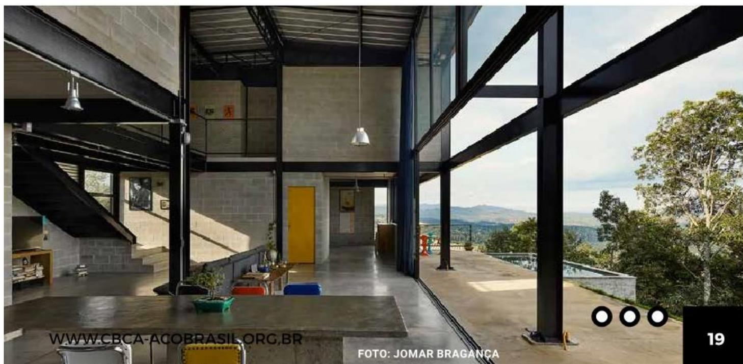
E qual foi o grande desafio da obra? Marcos responde: “Foi trabalhar a modulação, a interface dos blocos com a estrutura de aço e dos fechamentos em si, além dos projetos complementares das instalações hidráulicas e elétricas, que por estarem aparentes, demandaram um plano que seguisse os eixos estruturais e que fossem esteticamente agradáveis”.
